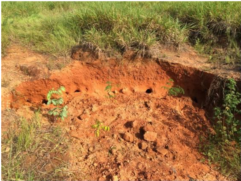
Parte ainda ativa da voçoroca com as novas mudas plantadas.
